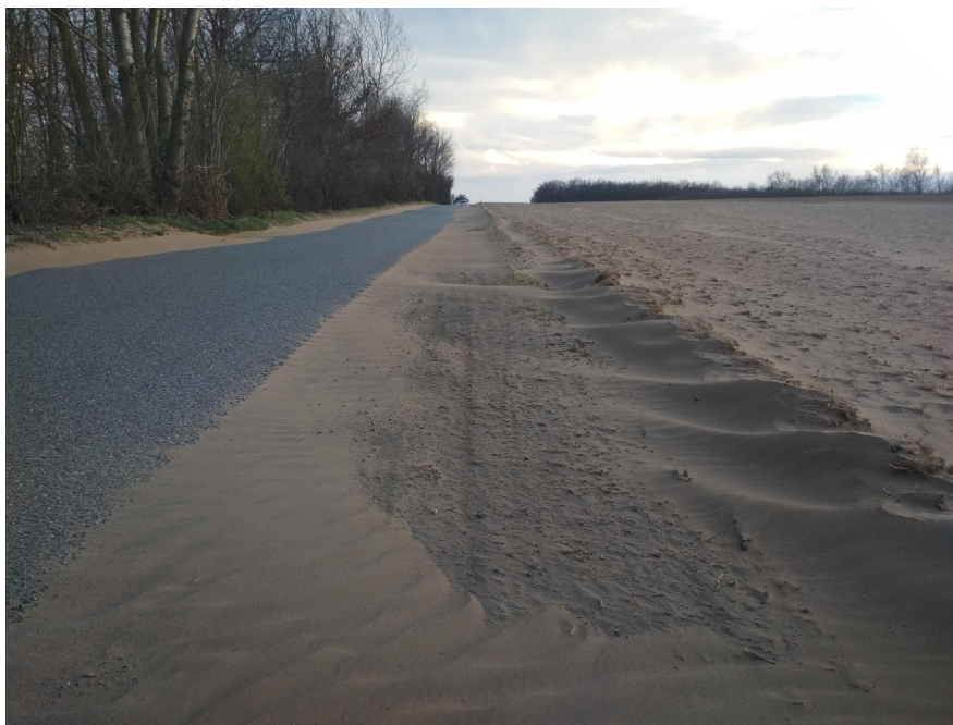
Obr. 11: Projevy větrné eroze v k.ú. Mutěnice
