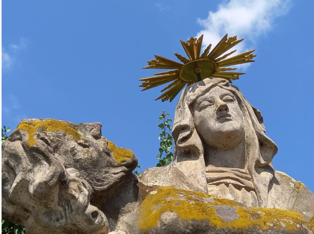
Sousoší piety, Prostějov-Vrahovice, detail Kristovy a Madoniny tváře, patrné praskliny a degradace kamene, dále znečištění biodepozity a černými usazeninami – stav před restaurováním
