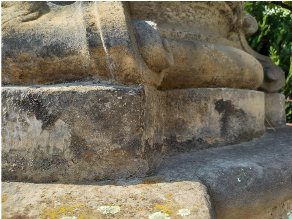
Sousoší piety, Prostějov-Vrahovice, detail dožilého spárování a znečištění prachovými depozity – stav před restaurováním
