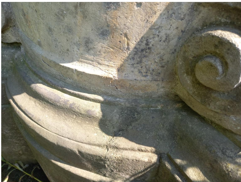
Sousoší piety, Prostějov-Vrahovice, detail profilace podstavce, patrné dožilé doplňky a spárování – stav před restaurováním
