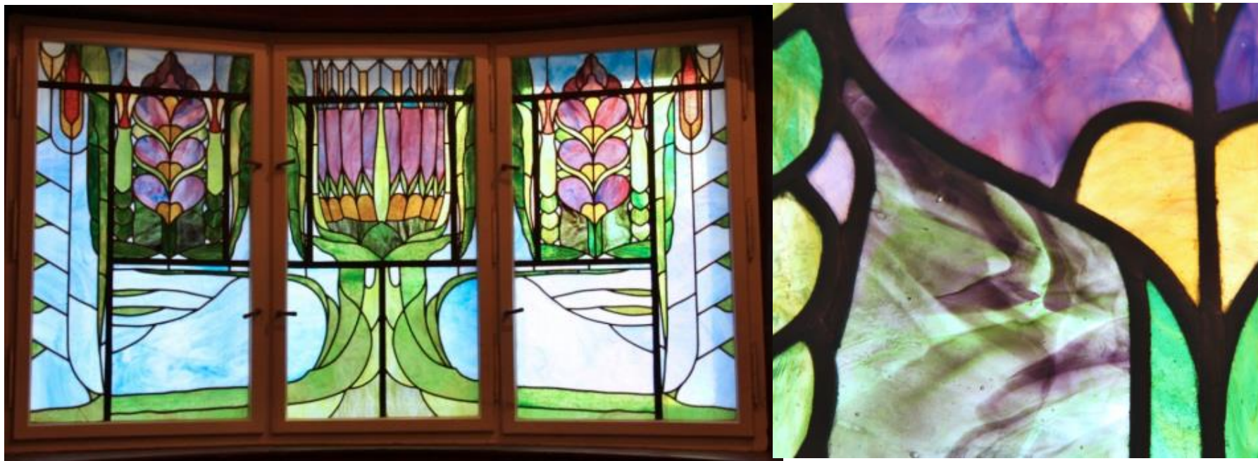
Suchardova vila - vitrážové okno v salonku včetně detailu, ze kterého je patrné využití opálových skel a řešení spojů jednotlivých polí olověnými pásky
